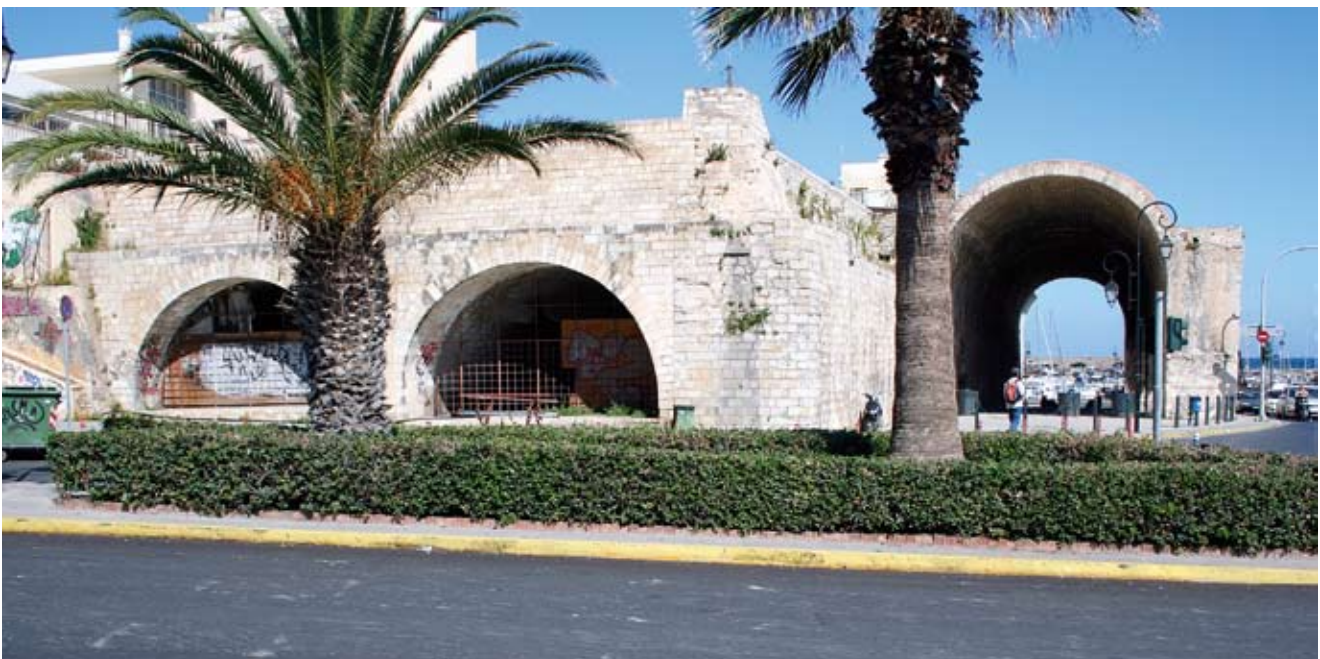
5. Iraklio, hale iz sklopa Arsenale Nuovissimo Heraklion, halls from the Arsenale Nuovissimo complex
